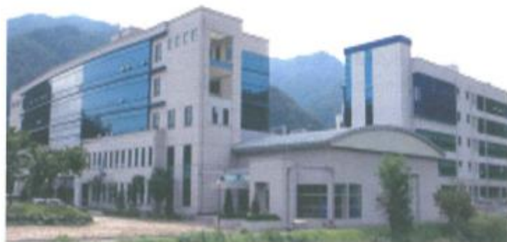
Слика 36. Поглед на центарот за заедничко истражување на Универзитетот Јонсеј и Фраунхофер
